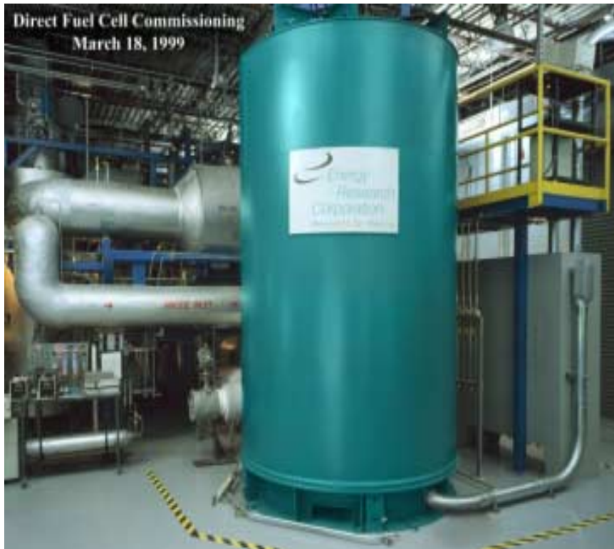
MCFC-Anlage der Firma "ERC" (250 kW el , Abwärme ~450°C)
