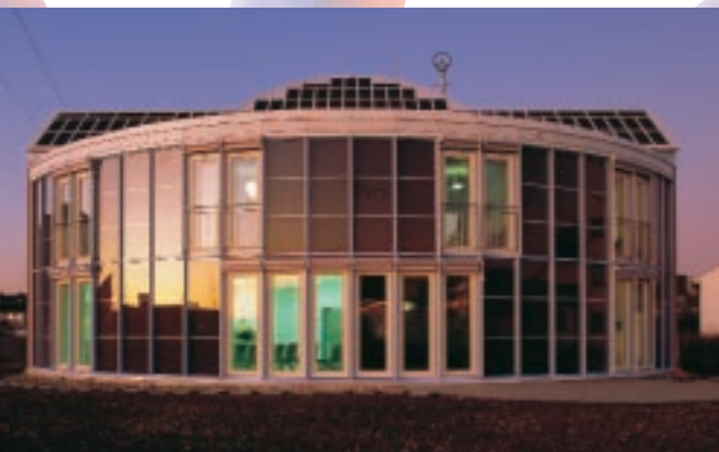
Projekt Energieautarkes Solarhaus (1992-95) mit solarer Wärmeerzeugung, photovoltaischer Stromversorgung und elektrischem Energiespeicher aus Batterie und Wasserstoff-System inklusive Brennstoffzelle, Elektrolyseur, Wasserstoff- und Sauerstofftank, Wasserstoff-Luftvorwärmung und Wasserstoff-Herd.
