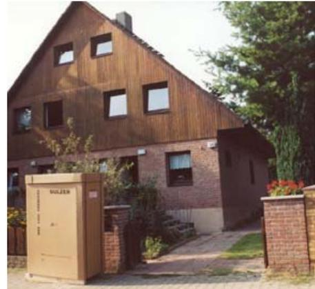
Das Brennstoffzellen-Heizgerät besteht aus der eigentlichen SOFC (Solid Oxide Fuel Cell) und einem Zusatzbrenner. Die Brennstoffzelle reformiert intern das Erdgas und wandelt es bei hohen Temperaturen in wasserstoffreiches Gas um. Sie soll Strom mit einer Bruttoleistung von maximal 1 Kilowatt erzeugen, der direkt in das öffentliche Netz eingespeist wird. Zeitgleich wird Wärme mit einer Leistung von maximal 2,5 Kilowatt erzeugt (Zielwerte).
